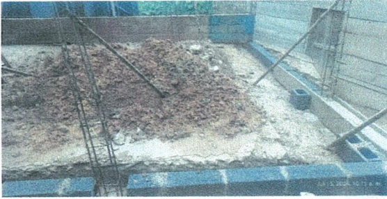
Foto 1: Mejoramiento modulo de corredor.
