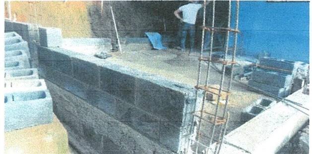
Foto 4: Mejoramiento modulo de cocina.
