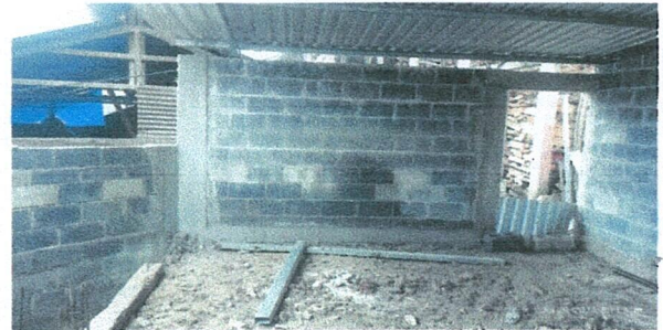
Foto 4: Mejoramiento modulo de corredor.
