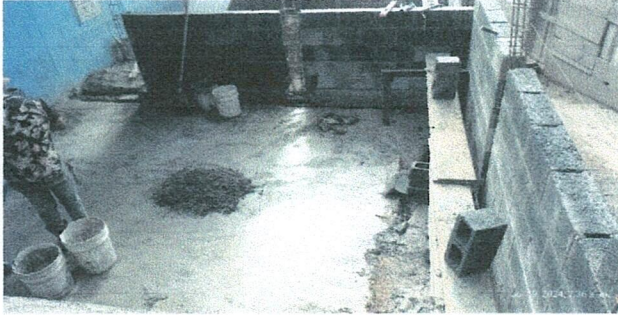
Foto 1: Mejoramiento modulo de cocina.
