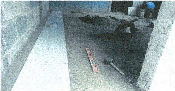
Foto 3: Mejoramiento de piso (Cerámico de alto impacto)
