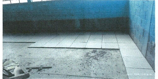
Foto 2: Mejoramiento de piso (Cerámico de alto impacto)
