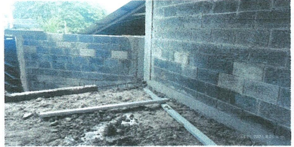
Foto 2: Mejoramiento modulo de corredor.
