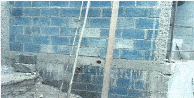
Foto 3: Mejoramiento modulo de corredor.
