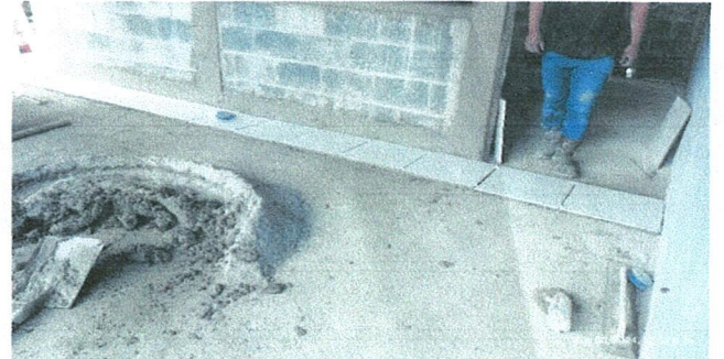
Foto 4: Mejoramiento de piso (Cerámico de alto impacto)
