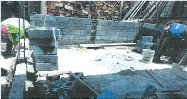
Foto 3: Mejoramiento modulo de cocina.
